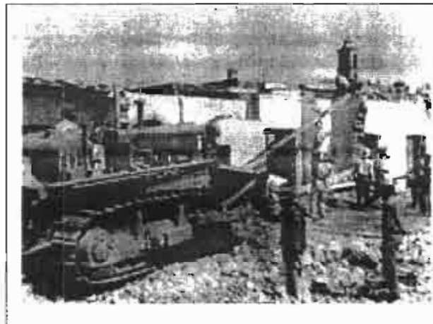
Fotografía 3.1. Demolición de casas en la calle de Corregidora. 1963. (Galván E., 1963).
