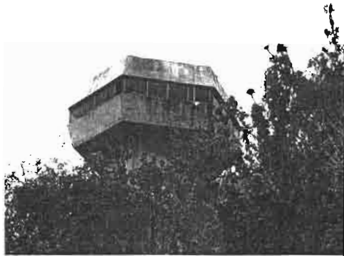
Penitenciaría de Barrientos Estado de México
