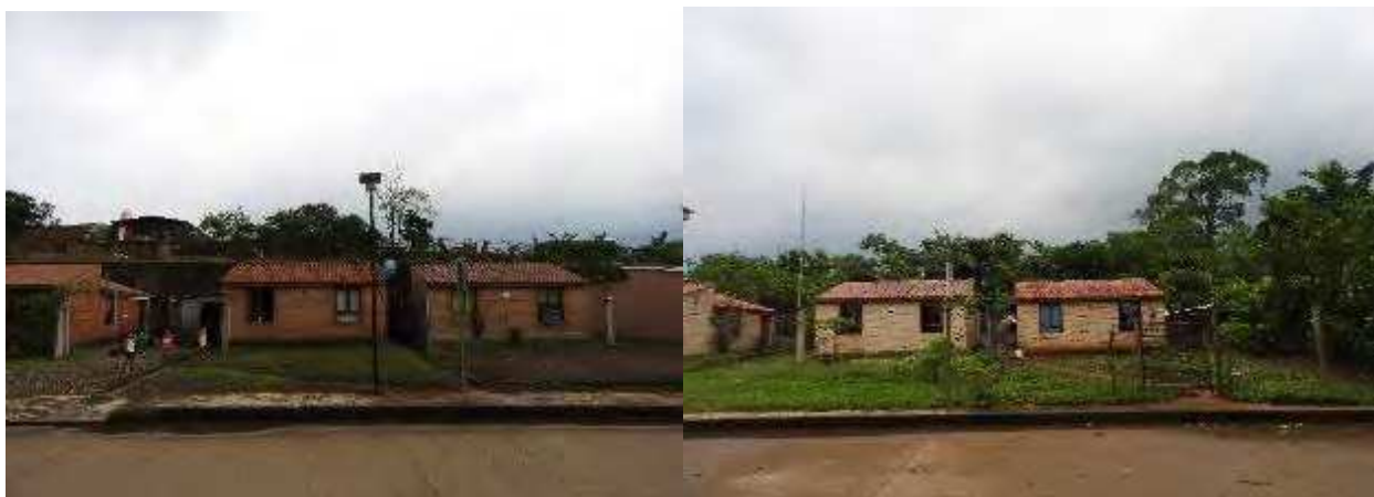
Foto 32. Viviendas de la Ciudad Rural Sustentable “Nuevo Juan del Grijalva” 2011
