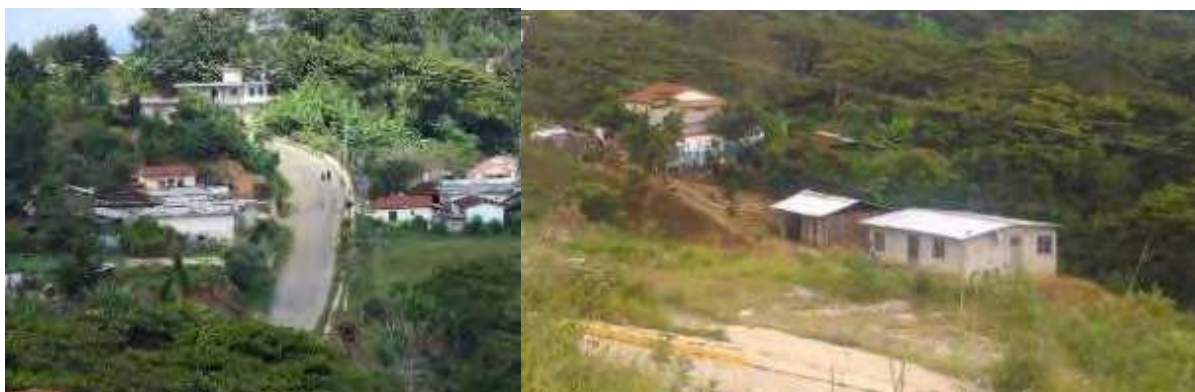
Foto 136, Foto 137. Carretera hacia Choyó y Pushiló
