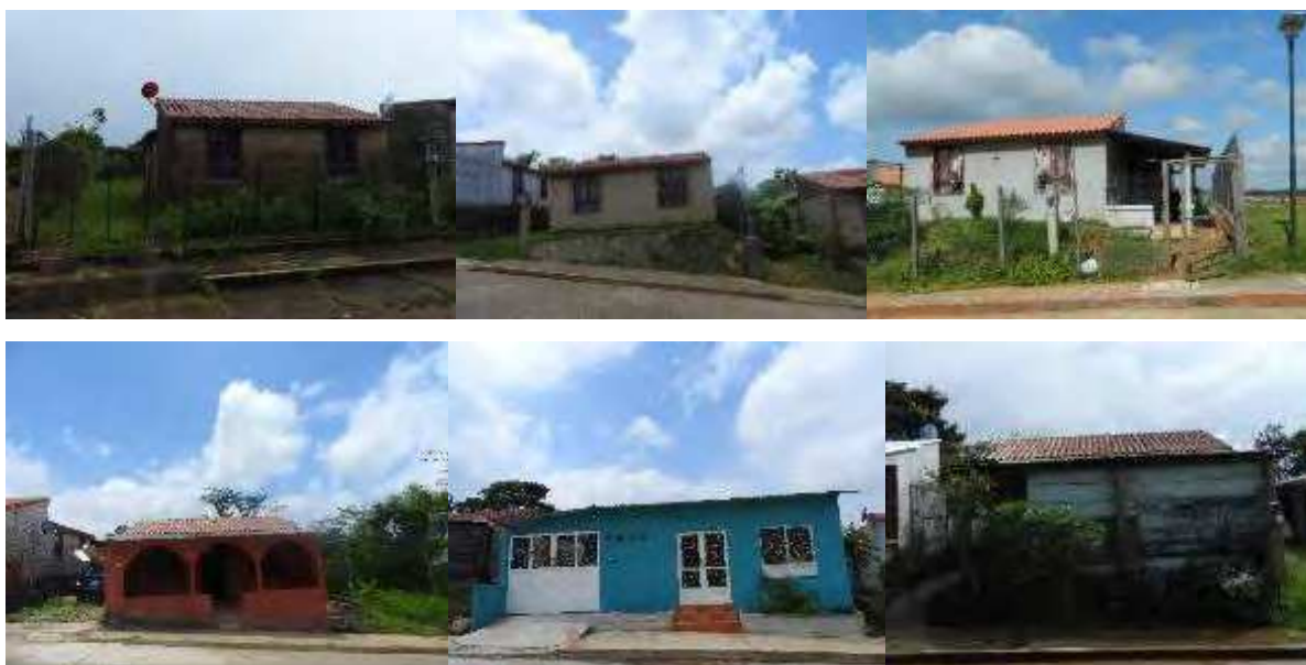
Foto 73, Foto 74, Foto 75, Foto 76, Foto 77, Foto 78. Transformación de fachadas en la Ciudad Rural Sustentable “Nuevo Juan del Grijalva”
