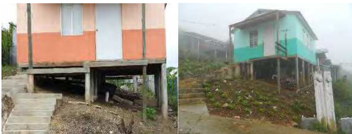
Foto 240, Foto 241. Detalle cimentación en la Ciudad Rural Sustentable “Santiago El Pinar”
