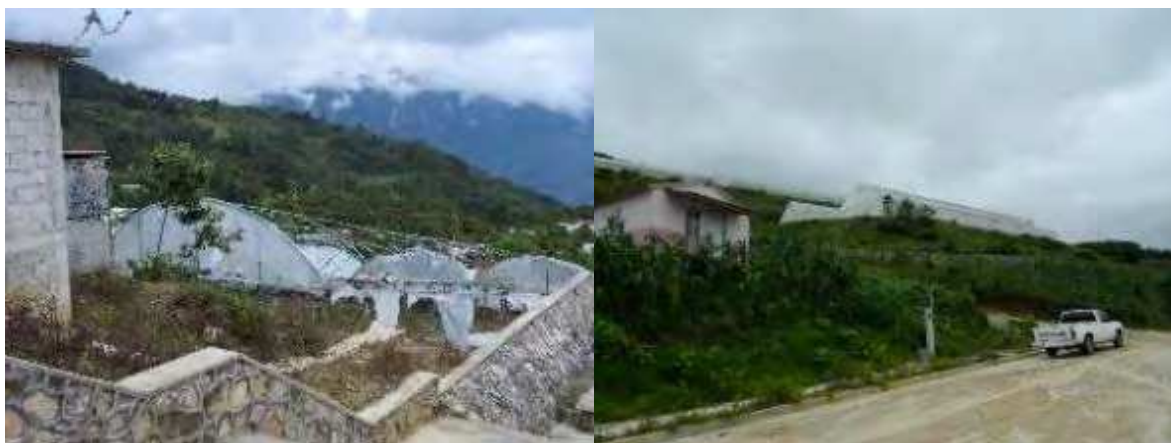
Foto 104, Foto 105. Abandono de infraestructura de proyectos productivos
