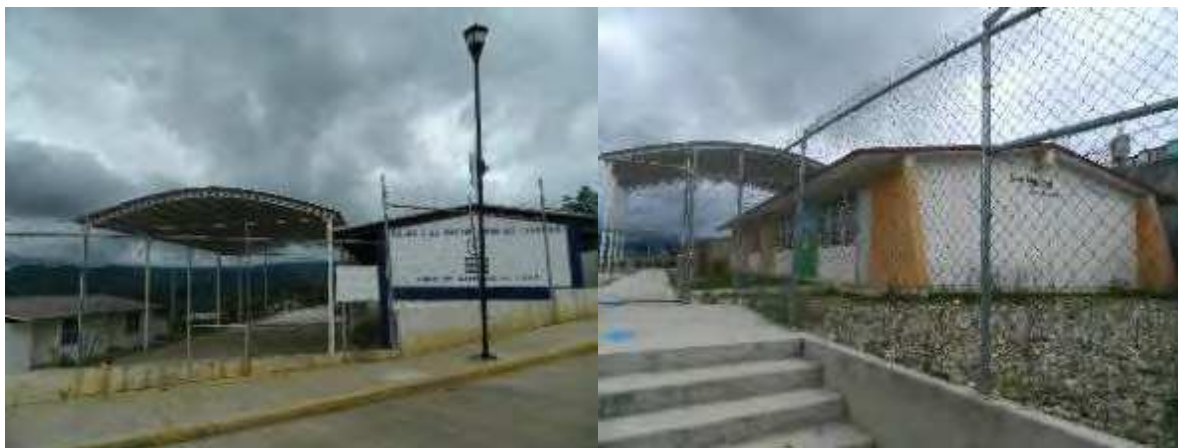
Foto 114. Colegio de Bachilleres de Chiapas
