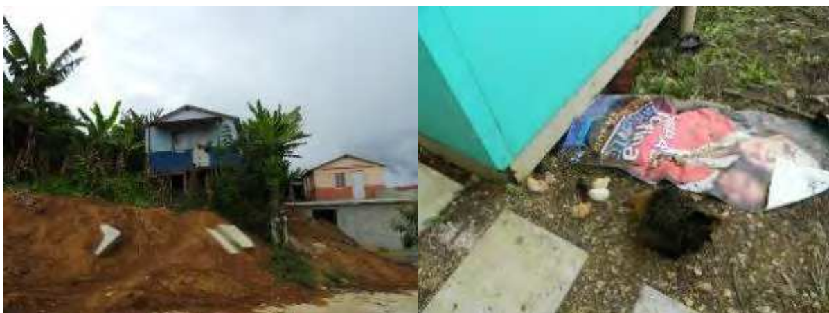
Foto 172. Deslizamiento y vivienda ampliada
