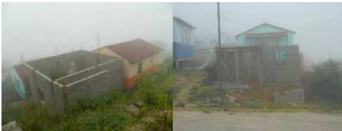
Foto 160, Foto 161. Construcción nueva en el lote que corresponde a la vivienda de la Ciudad Rural Sustentable "Santiago El Pinar"
