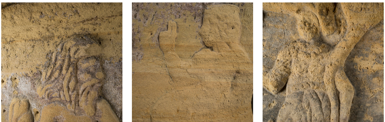
Figuras 22, 23 y 24. Algunos de los deterioros visibles en los relieves de las grutas de Osimo. Fuente: Distori Heritage, 2019.
