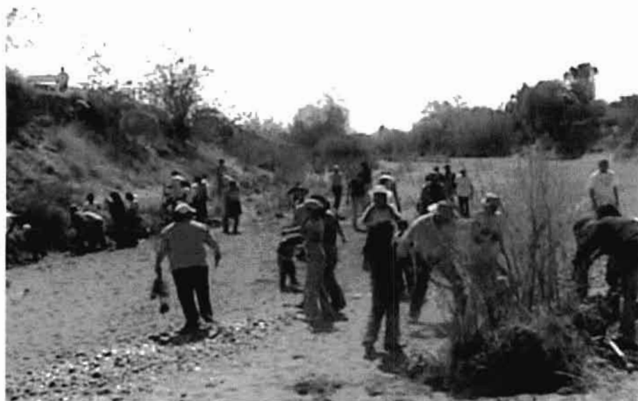
08 Fotografía de la cooperativa. Trasplante de árboles del centro del cauce a las orillas para proteger los taludes.
